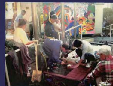
現場製作の様子
